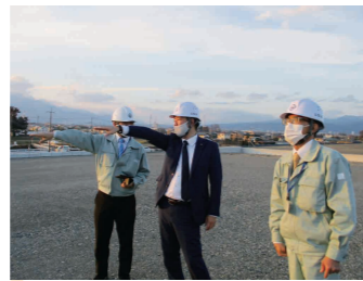
新山梨環状道路建設現場視察
